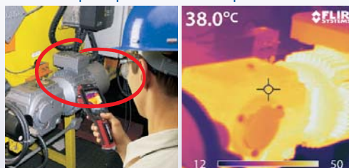
Обследование механической части мотора с помощью тепловизора FLIR i60.
