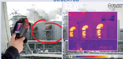
Профилактическое обследование выхлопных труб
